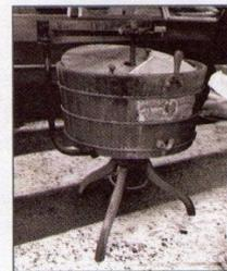
② **Principe :** il faut verser l'eau chaude dans la machine et brasser le linge avec une manivelle pour le laver.
