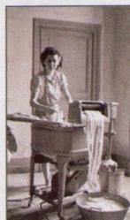
③ **Principe :** la manivelle pour brasser le linge est reliée par une courroie à un moteur électrique et tourne toute seule.
